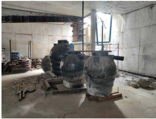
ภาพที่ 9.ระบบบำบัดน้ำเสียจากห้องน้ำ
